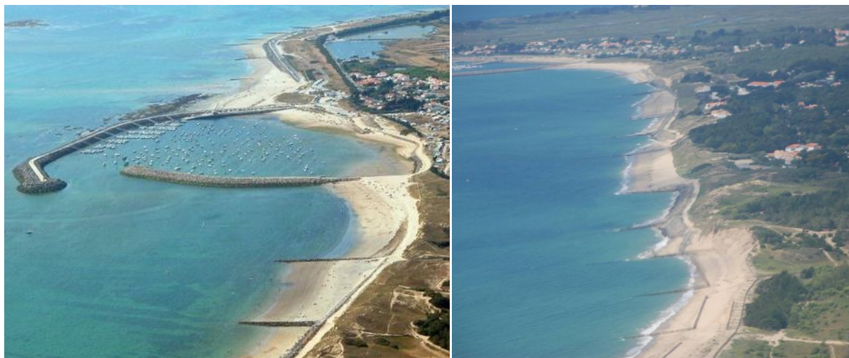
Les plages sont en forte érosion au sud du port (source : la Vigie)
