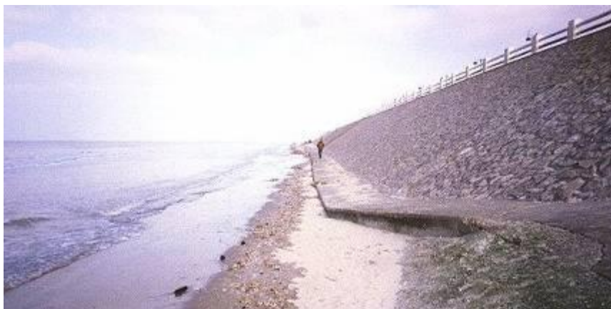
Protection du haut de plage par perré en Picardie (source : www.u-picardie.fr )
