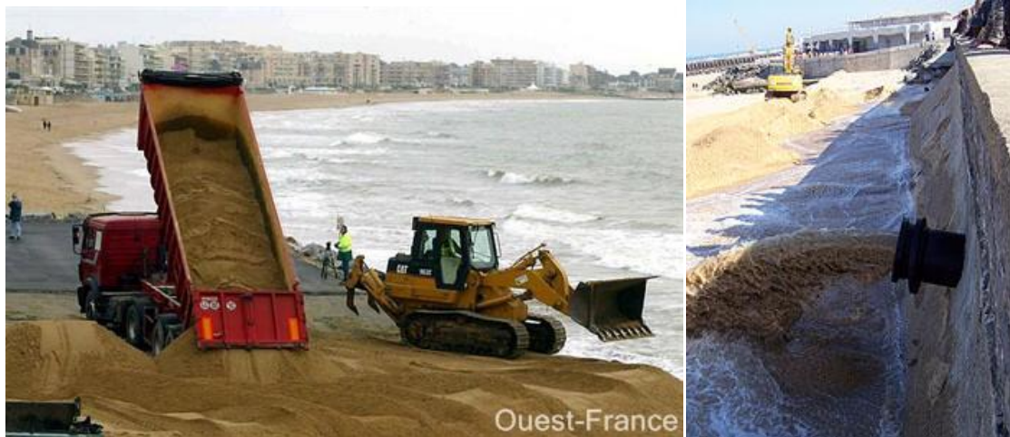
Rechargement de la plage de la Baule et bypass de Capbreton (sources : Ouest-France et Mairie de Capbreton)
