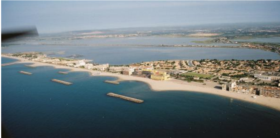
Protection par brise lames à Palavas les Flots (source : EID Méditerranée)
