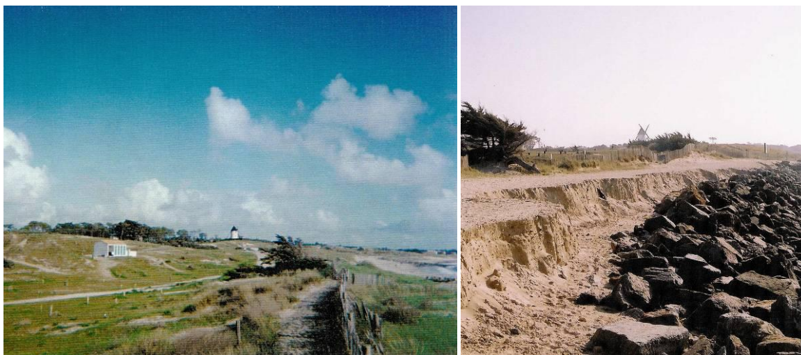
Au sud du port en 1993, puis en 2003. Témoin du recul : le cupressus échevelé (source : 12sur12)
